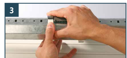
Befestigungsringe einrasten – fertig!
